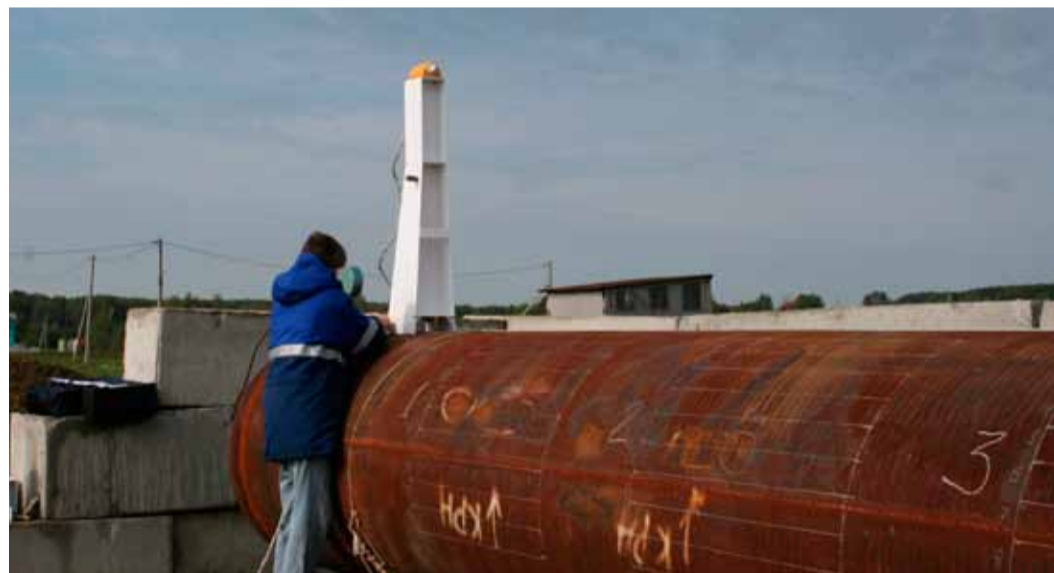
Измерение магнитного поля при проведении гидроиспытаний дефектной трубы
